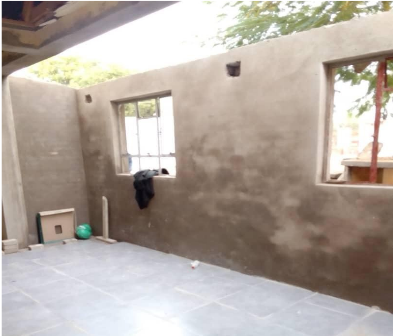
Die Mauer wird für die Erweiterung des Erholungsbereichs umgebaut
